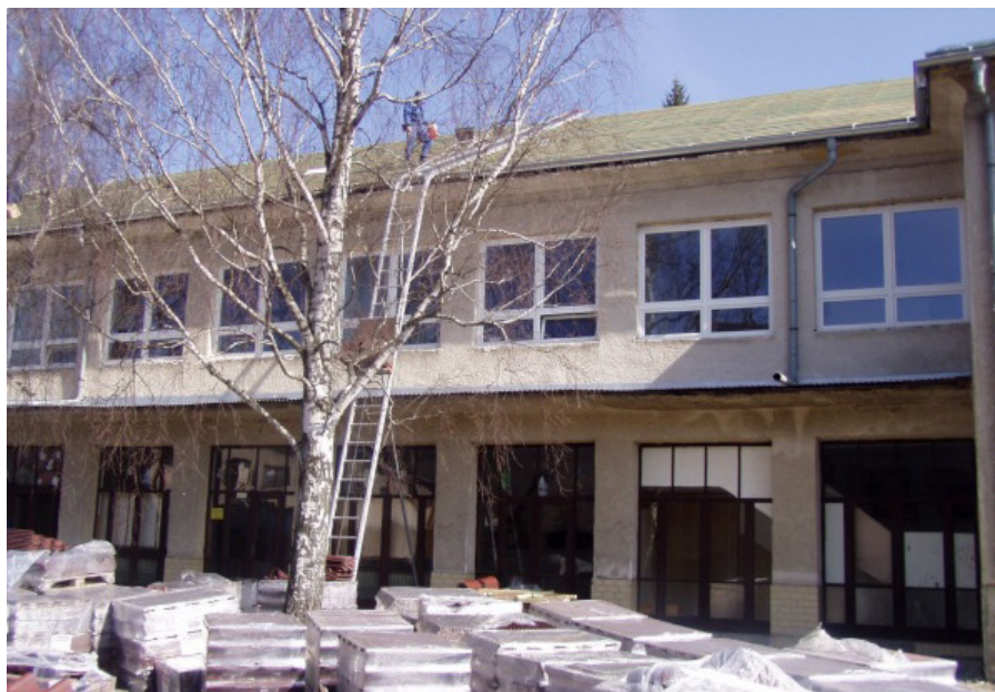
Rekonštrukcia strechy ZŠ, rok 2011
