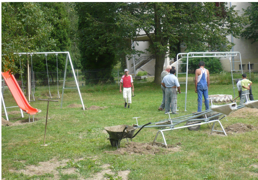
Rekonštrukcia detského ihriska, rok 2007
