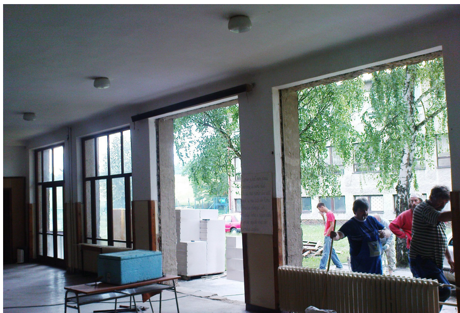
Rekonštrukcia chodby v ZŠ, rok 2011
