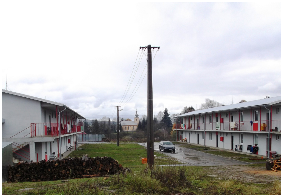
2x10 bytových jednotiek nižšieho štandardu, odovzdané do užívania v roku 2015
