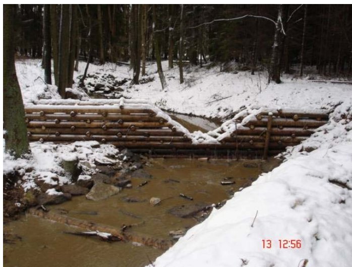
Pohľad na realizovanú zrubovú prehrádzku-vzor (zdroj: i-net)
